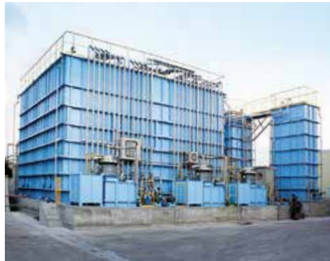
廃液受入タンク
