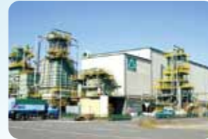
プラスチック製鉄原料化工場
